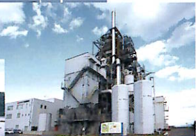
岩国バイオマス発電所
