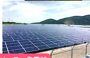
富津ソーラー発電所
